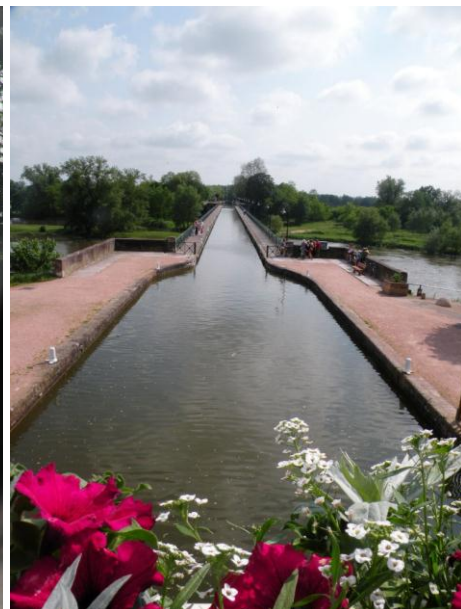
Le Pont canal de Digoin sur la Loire
