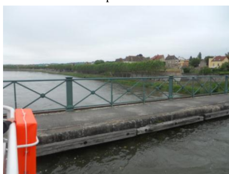
Le canal au-dessus de la Loire
